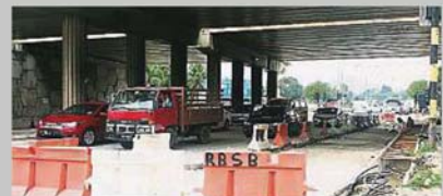
承包商进行加宽车道和修筑渠道工程时,被迫收窄道路,继而影响交通。
