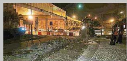
为了避免影响交通,承包商都在晚上10时至隔天清晨5时之间施工。
